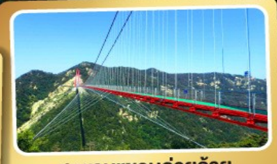
สะพานแวงนอ้ายจ้าย
