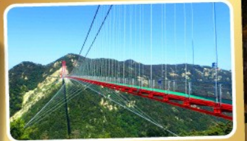
สะพานแวงนอ้ายจ้าย
